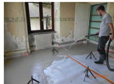
La chape liquide a été coulée dans toutes pièces du rez-de-chaussée
